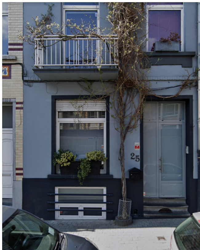
FIG. 6 Voorbeeld van een groene gevel via DWC Vanhuffel • Van Bergenstraat Foto : Streetview Google, april 2019
